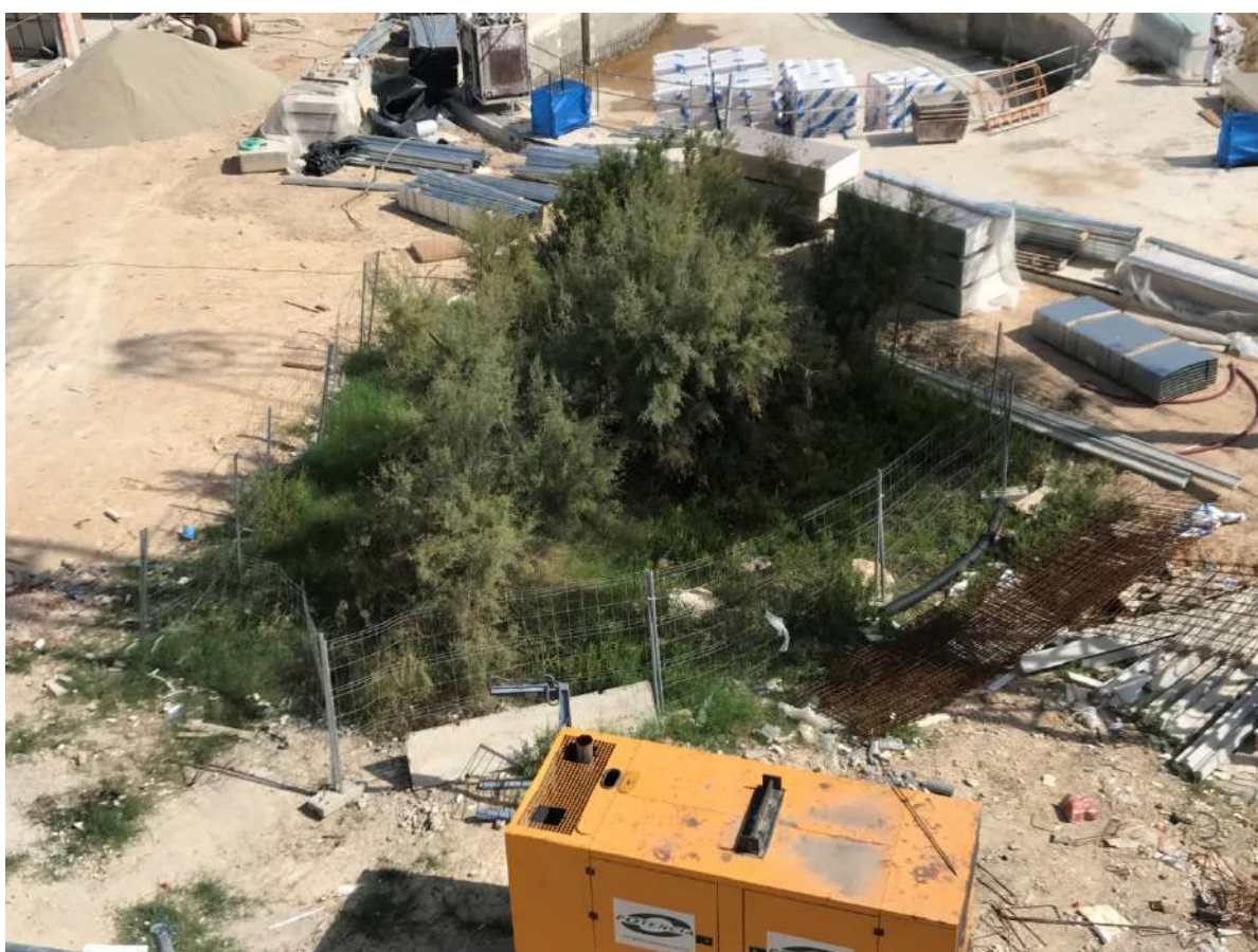
Vallado metálico perimetral de protección de los tamariscos trasplantados en el interior de la Fase 1.
