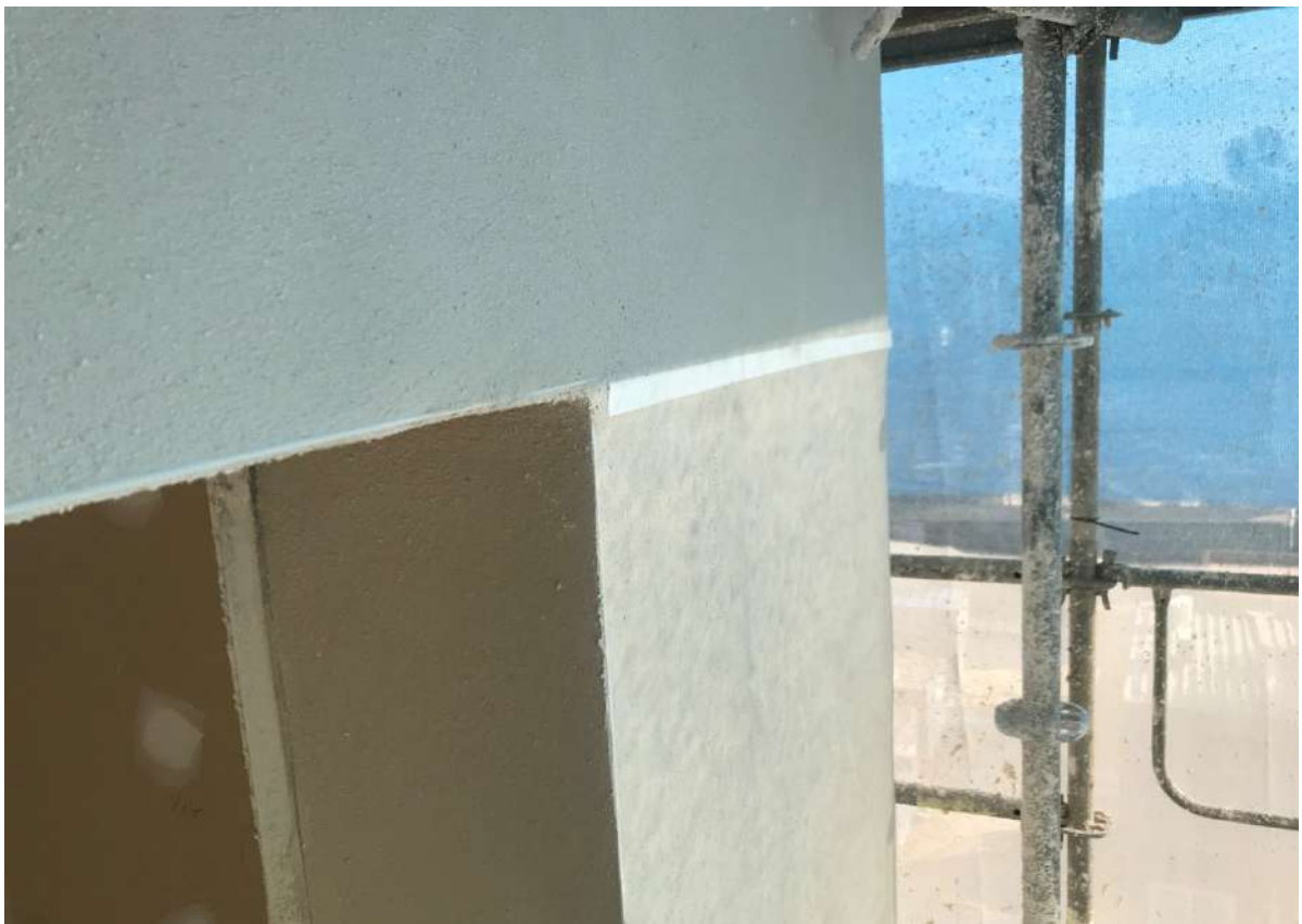
Las imágenes nos muestran el acabado final de las fachadas frontal y lateral derecha de la edificación más meridional de la Fase 2 de la RES-4 de Santa Ponça.
