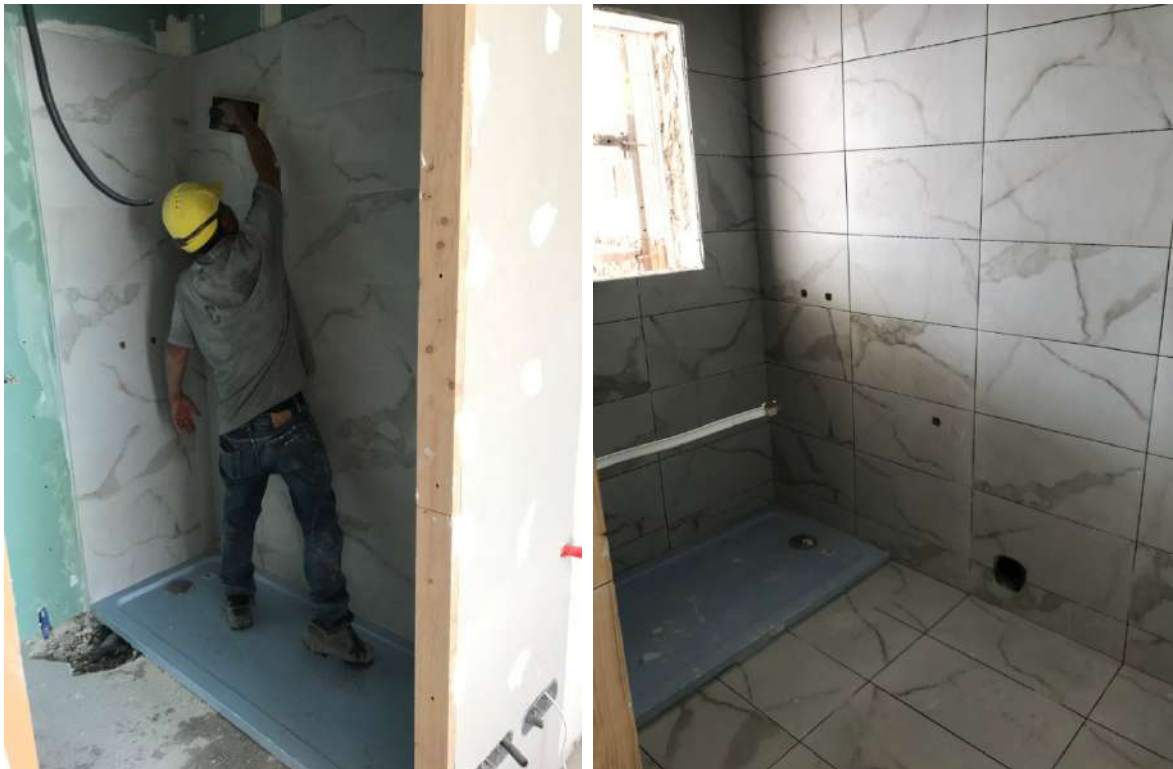
Imagen de un operario procediendo a sellar de forma manual las juntas de las baldosas de uno de los baños de la Fase 2. La otra imagen muestra un baño embaldosado y alicatado con sus respectivas juntas.
