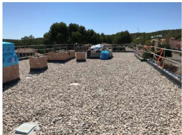
Imágenes de la Fase 1 (dos primeras) y de la Fase 2 (resto) en las que se aprecian las actuaciones aislamiento térmico de las cubiertas de estos edificios residenciales.
