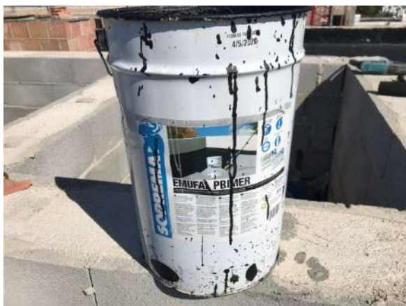
Emulsión asfáltica para imprimación de superficies y lámina de betún plastomérico.
