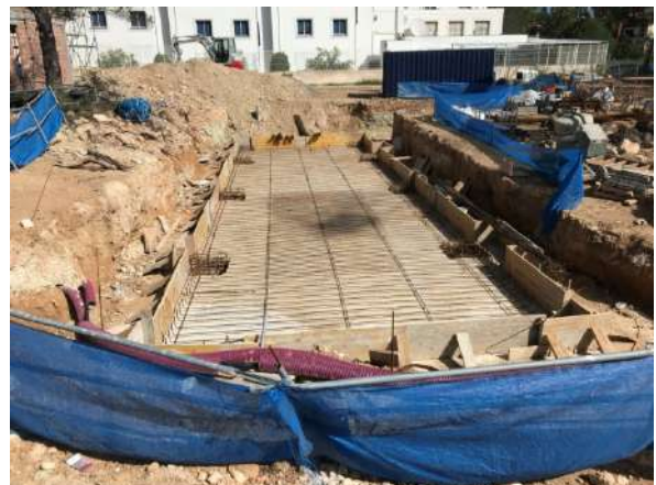
Hueco previsto para el establecimiento de la sala de máquinas de la piscina y armado de la placa base de la piscina sobre el hormigón de limpieza.
