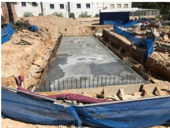
Placa base de la piscina fraguada y levantamiento de las paredes del vaso mediante planchas metálicas para relleno con hormigón armado.
