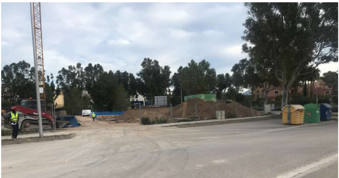
Acceso rodado para vehículos pesados dispuesto en la esquina sureste de la Fase 1.
