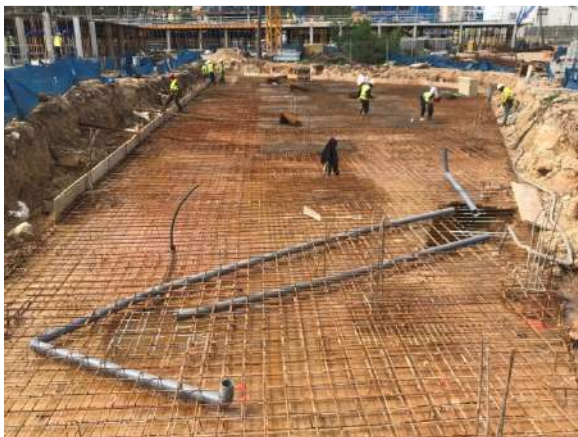
Mallazos y conducciones que conforman la base de la piscina a establecer en la Fase 1 de las obras de la RES-4. La segunda imagen nos muestra la placa base consolidada así como los arranques de los futuros muros de cierre y paredes del vaso de la piscina.
