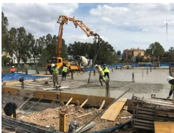
Labores de vertido y aplanado del hormigón del forjado de la planta baja de la edificación residencial emplazada al norte de la Fase 1 de la urbanización. Este vertido de hormigón se realiza mediante motobomba a partir del suministro de camión hormigonera proveniente de planta.
