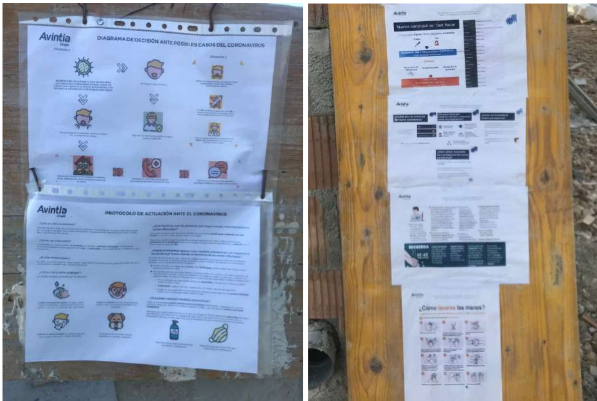
Imágenes correspondientes a la cartelería que la empresa constructora AVINTIA distribuyó por toda la obra mediante el establecimiento de paneles informativos.
