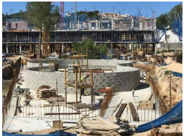
Las imágenes corresponden al cierre del vaso de la piscina mediante bloques de hormigón convenientemente armados y rellenos de hormigón.
