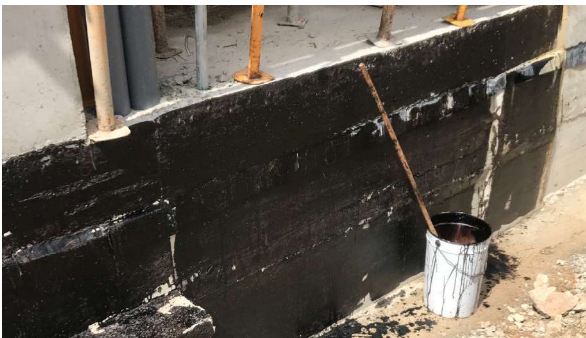
Aplicación en frío mediante rodillo de la emulsión bituminosa con caucho de color negro.
