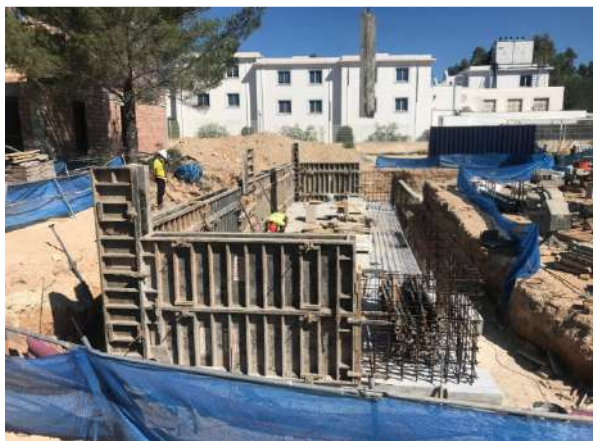
Placa base de la piscina fraguada y levantamiento de las paredes del vaso mediante planchas metálicas para relleno con hormigón armado.
