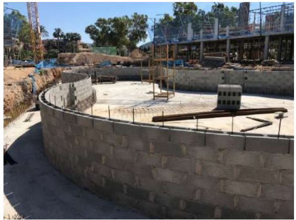
La imagen nos muestra la placa de hormigón armado que sustentará la futura piscina así como la forma redondeada de la misma remarcada sobre las varillas de arranque de la pared.
