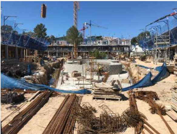
Las imágenes corresponden al cierre del vaso de la piscina mediante bloques de hormigón convenientemente armados y rellenos de hormigón.
