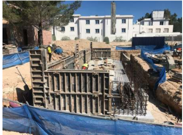
Hormigón armado depositado sobre la excavación compactada a modo de placa base sobre la cual asentar el fondo y las paredes de la piscina localizada en la Fase 2 de las obras.
