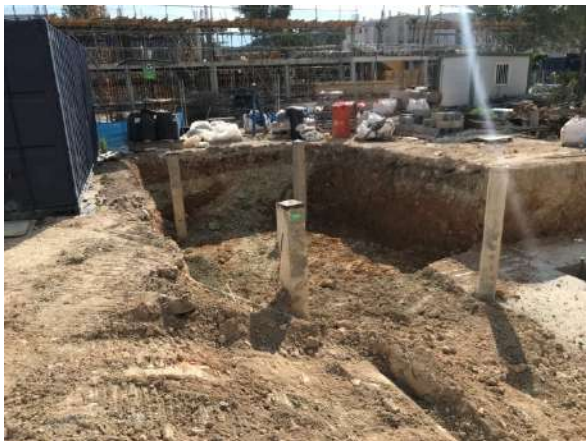
Hueco previsto para el establecimiento de la sala de máquinas de la piscina y armado de la placa base de la piscina sobre el hormigón de limpieza.
