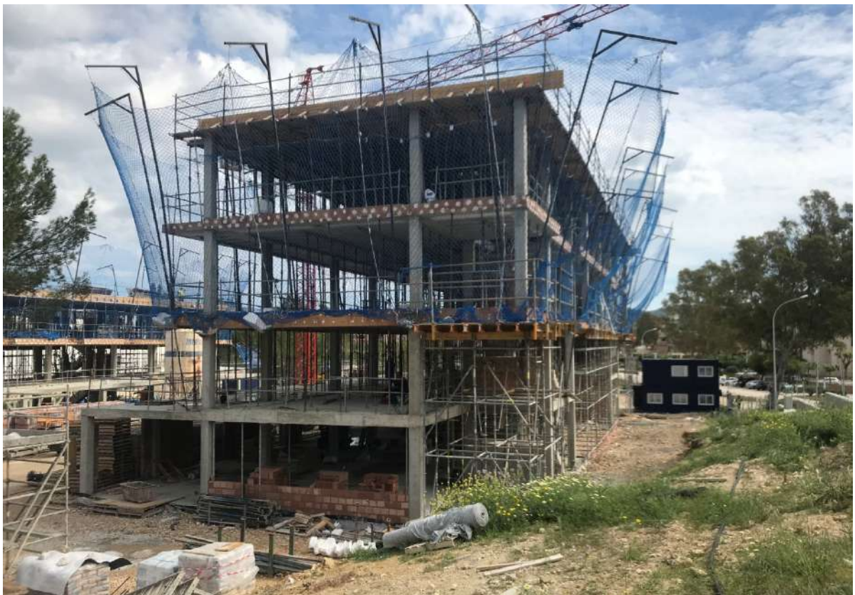
Estructura completada correspondiente a la edificación más meridional de la Fase 2. Nótese la estructura final del edificio compuesto por una planta baja y tres plantas piso.
