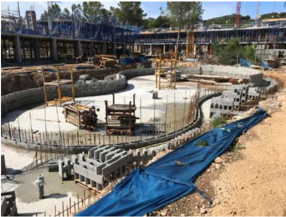
La imagen nos muestra la placa de hormigón armado que sustentará la futura piscina así como la forma redondeada de la misma remarcada sobre las varillas de arranque de la pared.
