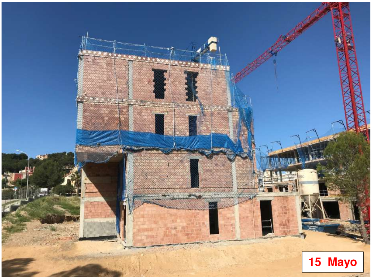
Evolución espacial del cerramiento exterior en el edificio más meridional de la Fase 2.
