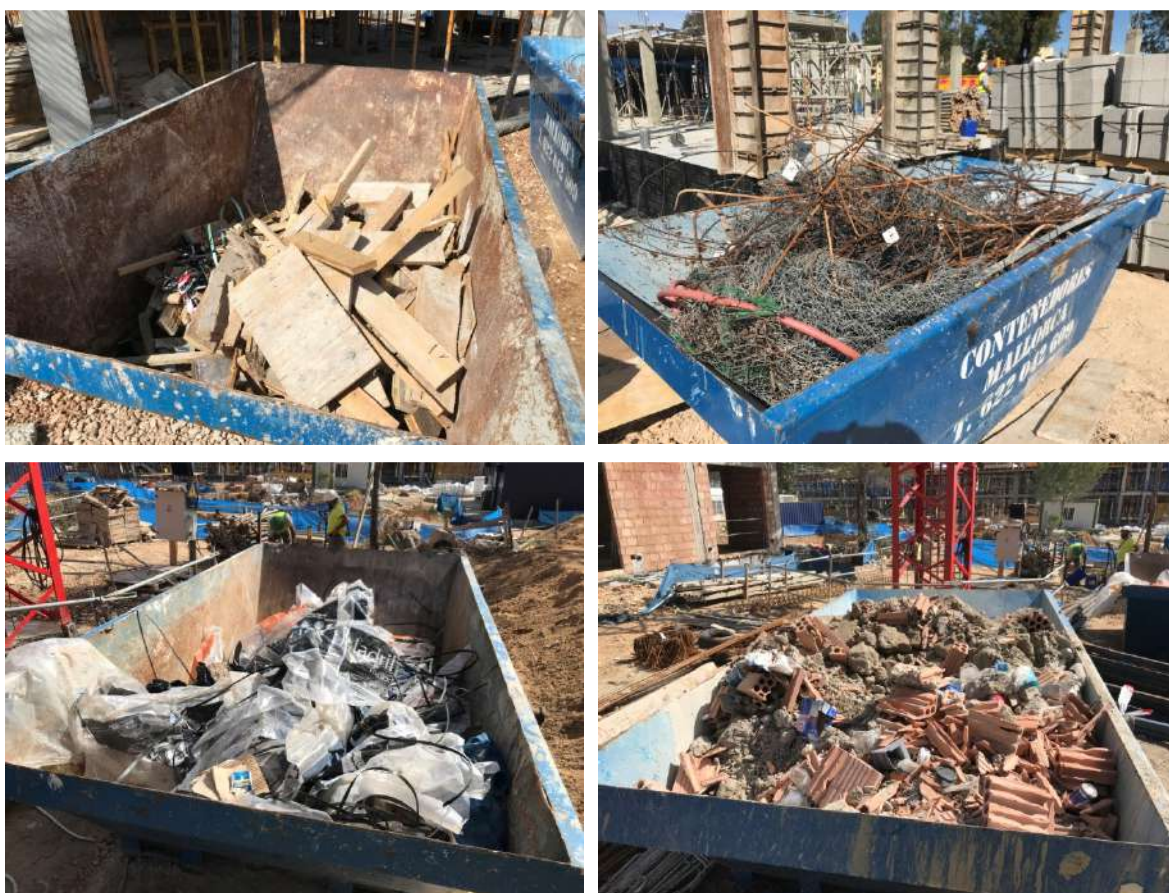
Contenedores dispuestos en las proximidades de los edificios residenciales en los cuales se aprecia como cada contenedor almacena un determinado tipo de residuo no peligroso (maderas / metales / plásticos / restos de bloques).
