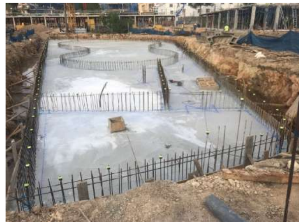
Mallazos y conducciones que conforman la base de la piscina a establecer en la Fase 1 de las obras de la RES-4. La segunda imagen nos muestra la placa base consolidada así como los arranques de los futuros muros de cierre y paredes del vaso de la piscina.
