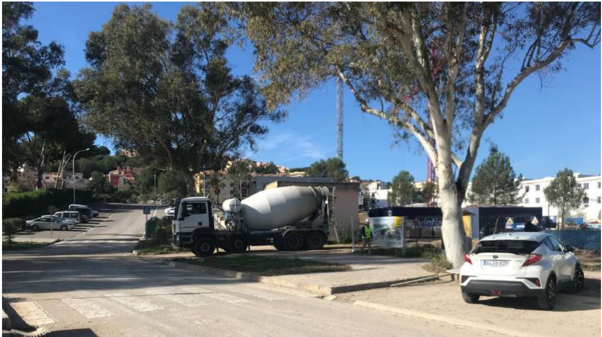
Camión hormigonera saliendo de la Fase 1 a través de la zona hormigonada que se establece sobre un parterre carente de vegetación que deberá ser repuesto cuando cesen las obras de construcción.
