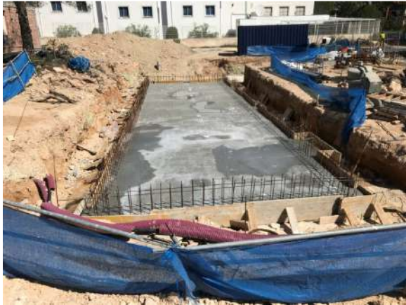
Hormigón armado depositado sobre la excavación compactada a modo de placa base sobre la cual asentar el fondo y las paredes de la piscina localizada en la Fase 2 de las obras.
