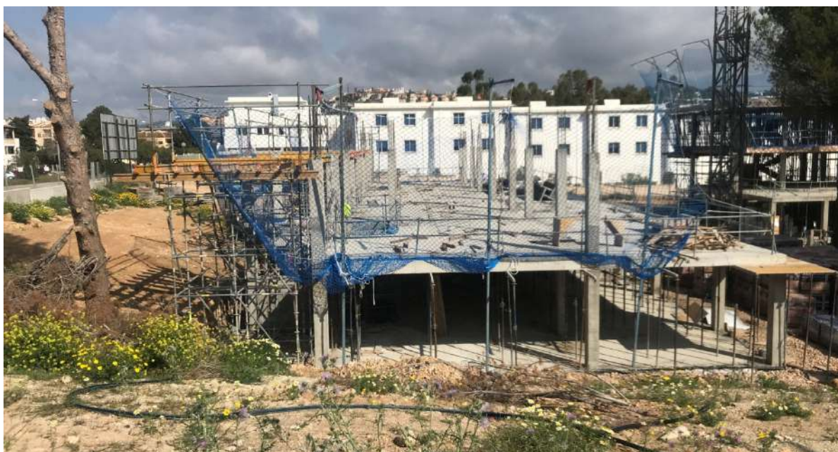
Levantamiento de la planta primera sobre la planta baja del edificio más occidental de la Fase 2.
