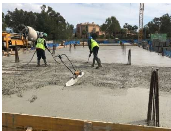
Labores de vertido y aplanado del hormigón del forjado de la planta baja de la edificación residencial emplazada al norte de la Fase 1 de la urbanización. Este vertido de hormigón se realiza mediante motobomba a partir del suministro de camión hormigonera proveniente de planta.
