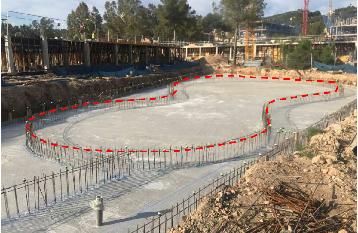
La imagen nos muestra la placa de hormigón armado que sustentará la futura piscina así como la forma redondeada de la misma remarcada sobre las varillas de arranque de la pared.
