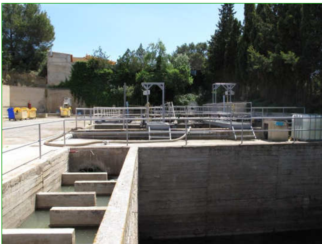
Ilustración 5. Laberinto de cloración y depósito
